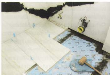
Beim Verlegen der Natursteinplatten kamen sich ergänzende PCI-Produkte zum Einsatz.
