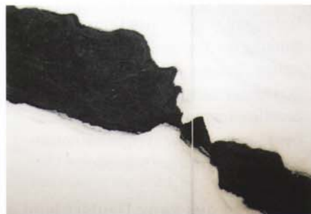
Die wenigen Fugen des Wand- und Bodenbelags sind mit einem hellen Fugenmörtel verfügt.
