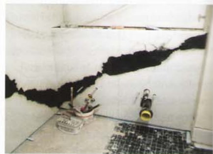
Die Bodenabdichtung wurde erst nach Abschluss der Ansetzarbeiten an der Wand hergestellt und an die aufgehende Abdichtung angearbeitet. So wurde möglichen Schäden an der Abdichtungslage vorgebeugt.
